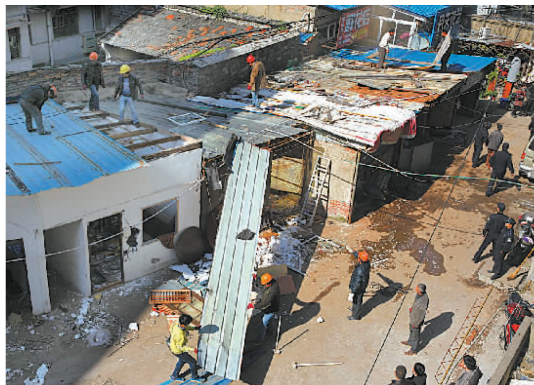
位于县学街167号、造成严重消防隐患的约600平方米违法建筑昨日拆除。(胡建华 谷叶 摄)
