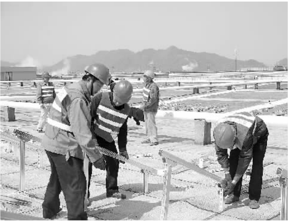
工人在申洲厂房屋顶安装光伏设备。（冯瑄 周律 摄）
