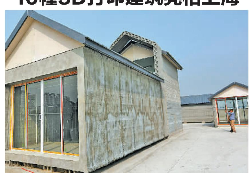
参观者在一幢3D打印小屋旁驻足(4月12日摄)。近日, 10幢3D打印建筑在上海张江高新区内揭开神秘面纱。这些建筑的墙体是用建筑垃圾制成的。
