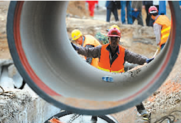
4月14日，施工人员进行输水管道敷设作业。(新华社记者 陈斌 摄)
