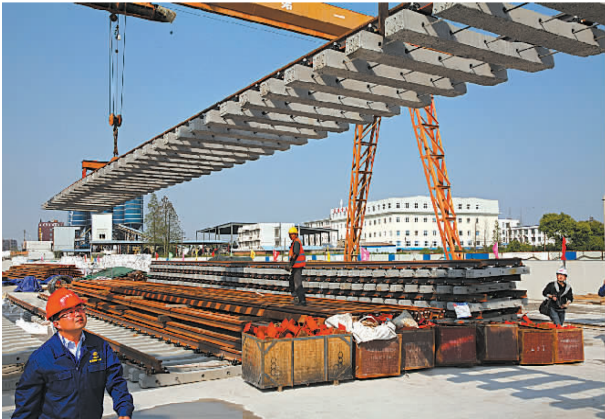
轨道交通2号线一期工程鄞州大道站黄隘出入段线，工人正在吊装轨排。（胡建华 摄）
