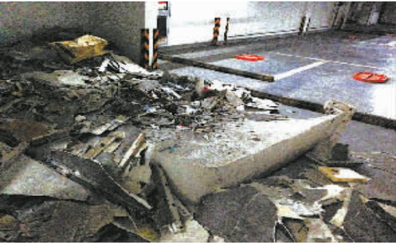
拆除的通风管堆在车位旁。（沈孙晖 摄）
