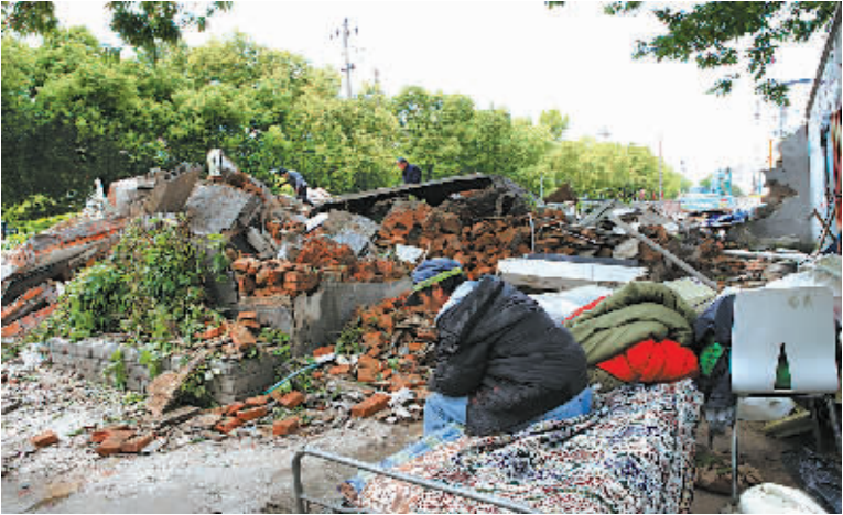
公厕被拆，“无家可归”的老刘望着瓦砾，颇为伤感。（记者 余建文 摄）
