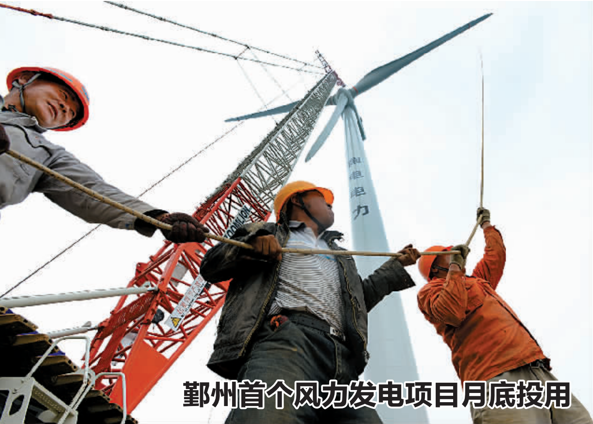
昨天下午,施工人员正在鄞州区横溪镇平均海拔400余米的白岩山顶安装风力发电机组。这是该区首个风力发电场,总投资3亿多元,由30组风力发电机组组成,首组计划于月底并网发电,全部建成后年发电量将达2亿千瓦时。(徐能 续大治 郑拓 摄)
