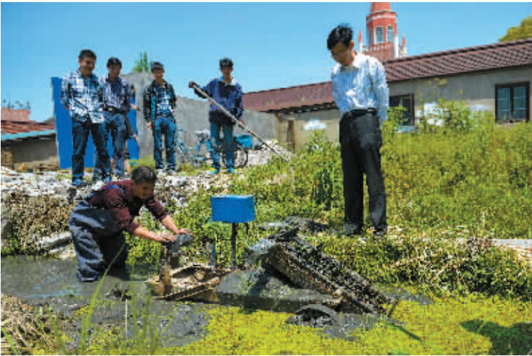
图为老沈（右）和徒弟在河中试验清淤船（通讯员 孙丰立 摄）
