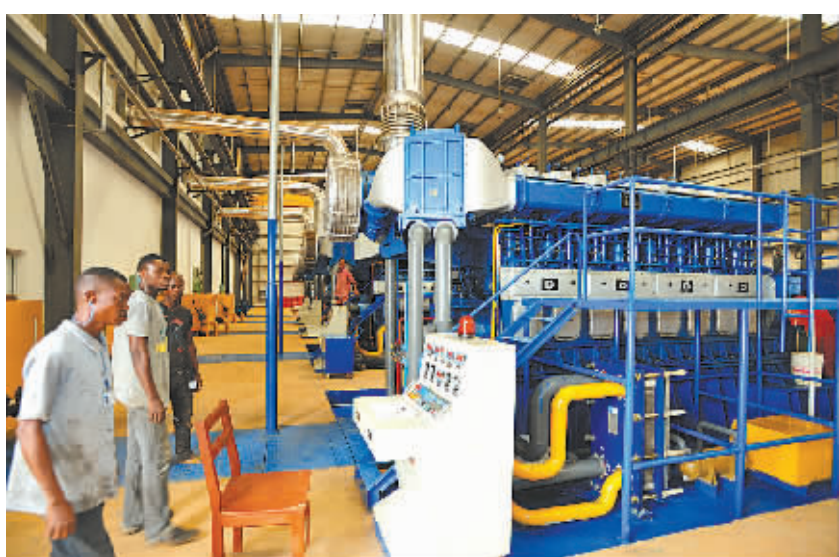
宁波中策动力机电集团有限公司在INNOPLAS建设的重油发电机组。 (记者 严龙 摄)
