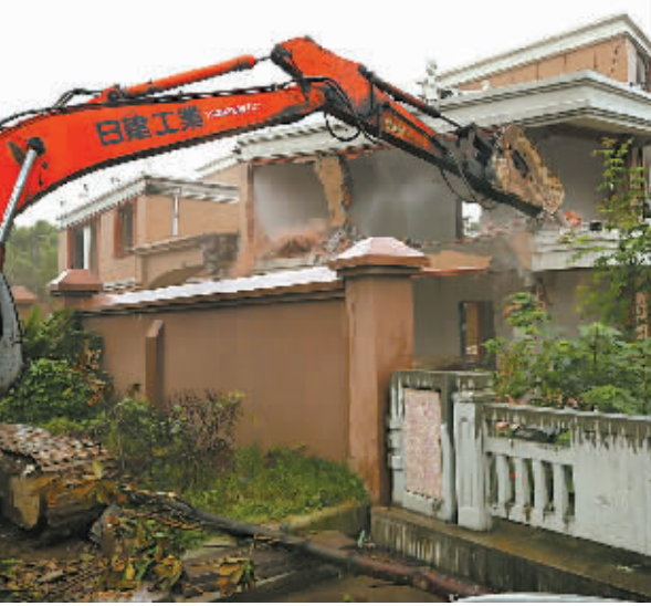
图为违建别墅被拆除。（胡建华 陈栋 摄）
