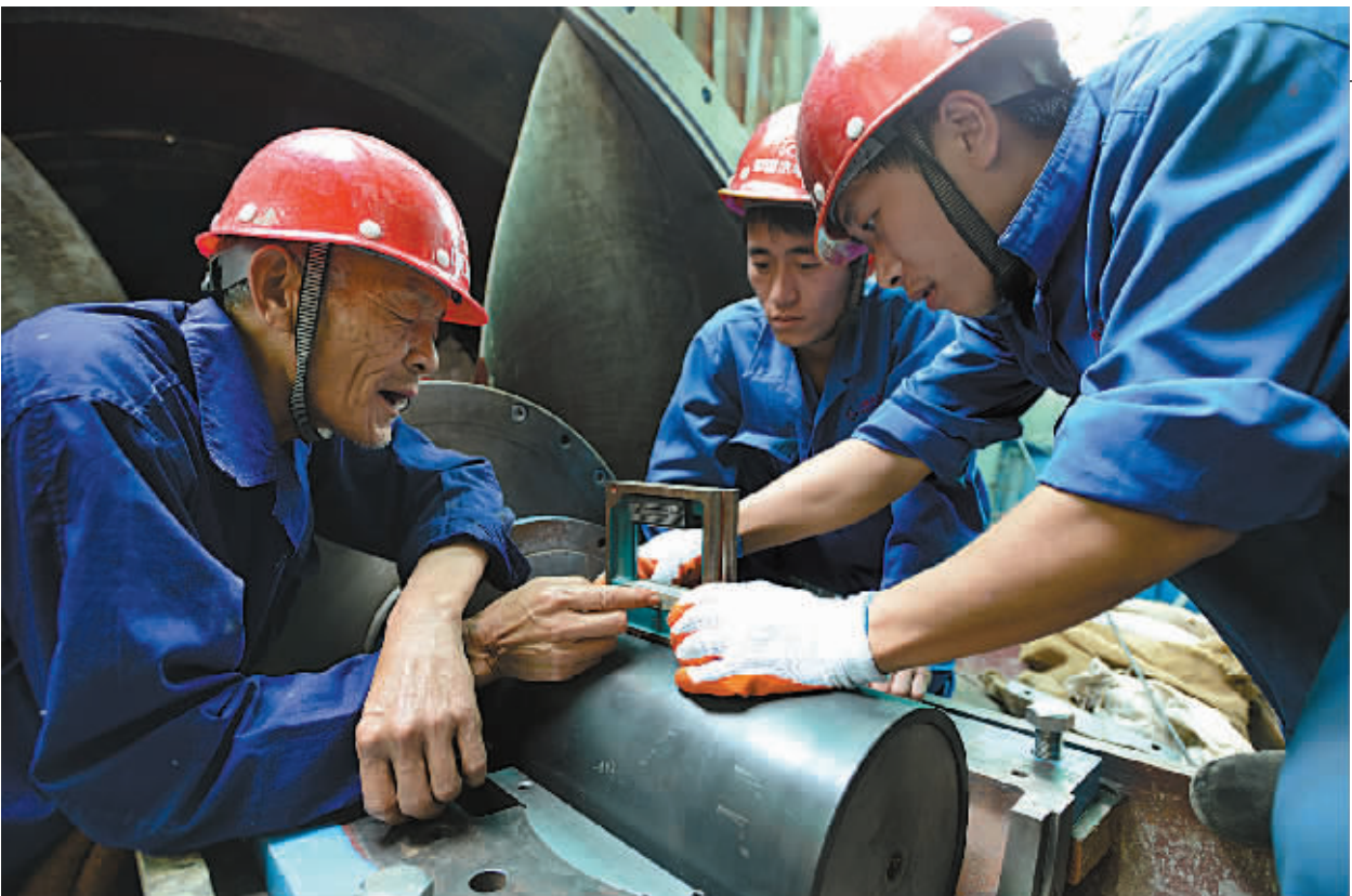
75岁、有着50多年安装经验的吴师傅(左一),前天应邀为鄞州区铜盆浦泵站做水泵机组精调。作为我市应急抢修工程之一,铜盆浦泵站工程是鄞东南平原防洪排涝体系中重要的排涝设施,预计本月底前具备通水条件。(徐能 赖淑萍 续大治 摄)
