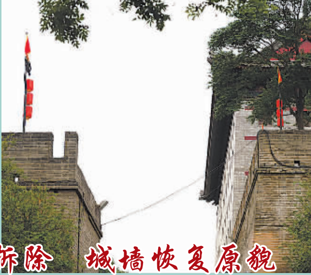
发公众关注。由于在实验性施工阶段就出现了一些争议，陕西省、西安市文物部门要求停工，对实验性设施进行拆除。7 月 8 日施工单位按照西安
