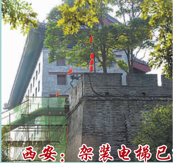
左图为 7 月 6 日拍摄的西安城墙电梯施工现场，右图为 7 月 10 日拍摄的恢复原貌的城墙。
