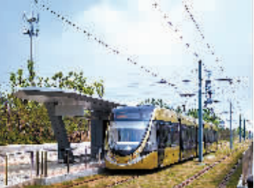
江苏首条低地板有轨电车线路——苏州高新区有轨电车 1 号线将于今年 10 月试运营。目前，该线路建设已经进入收尾阶段。
