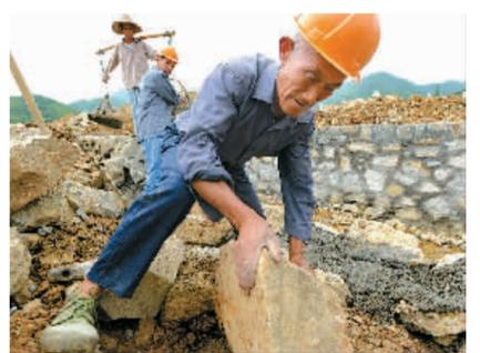
在象山涂茨镇东港村溪坑整治工程现场，施工人员正忙着砌石驳坎。主汛期临近，作为该村的主要排洪通道，工作人员加班加点对700余米长的溪坑进行坑面拓宽、两岸砌石、坑底清理等整治工作，目前已进入扫尾阶段。(徐能 陈光曙 徐杭波 摄)
