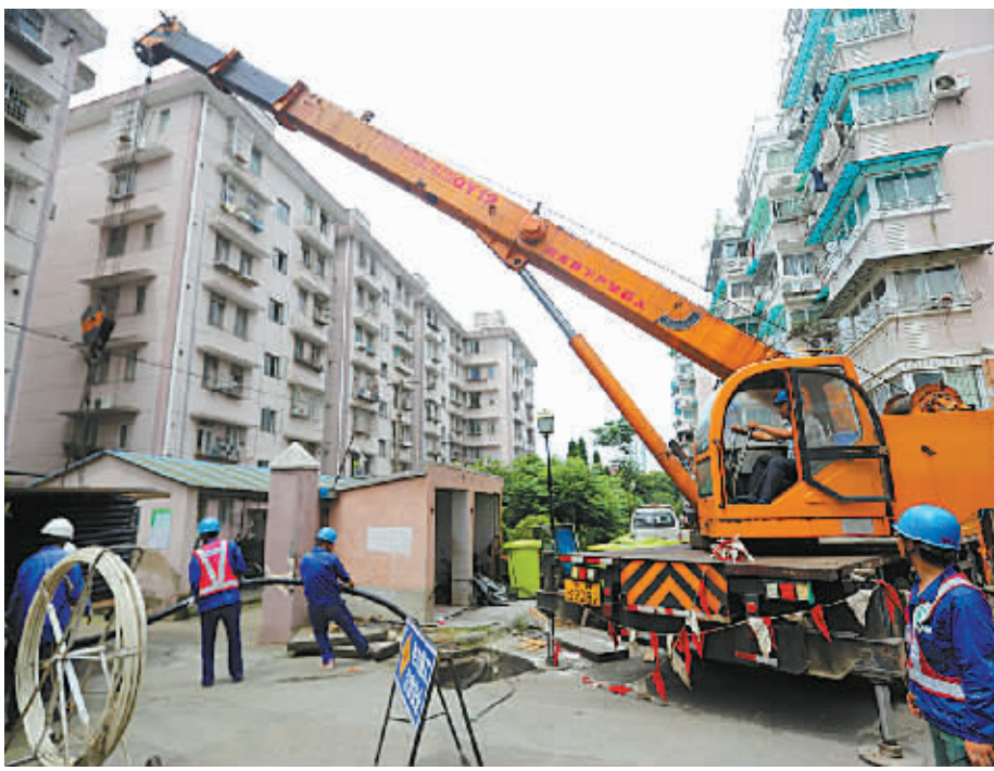
电力人员在柳馨花园小区进行“三双”施工。
