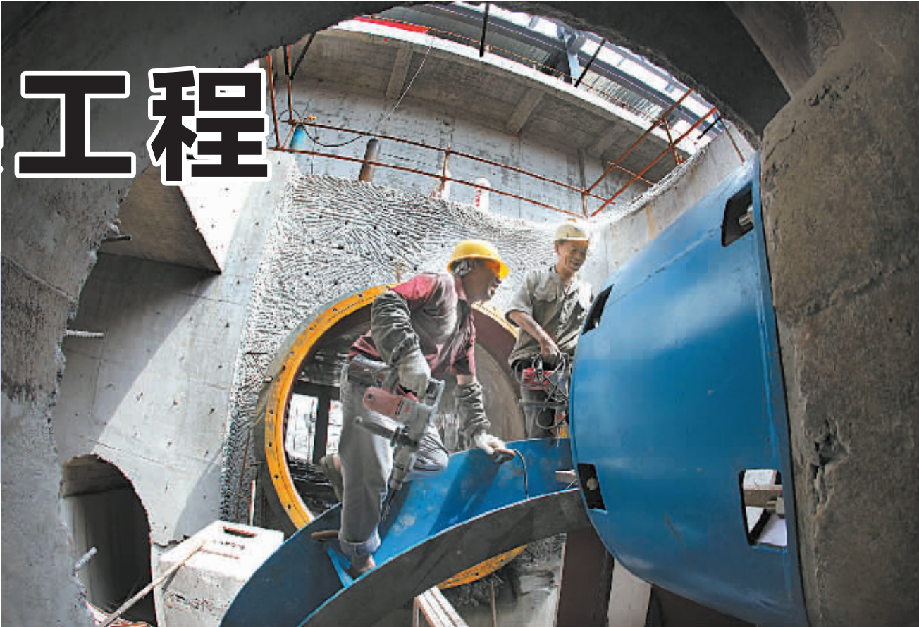
余姚市陶家路江泗门泵站机组安装基本到位。
