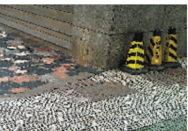
昨天，原本设立的隔离桩已拆除。(沈孙晖 侯沁言 摄)
