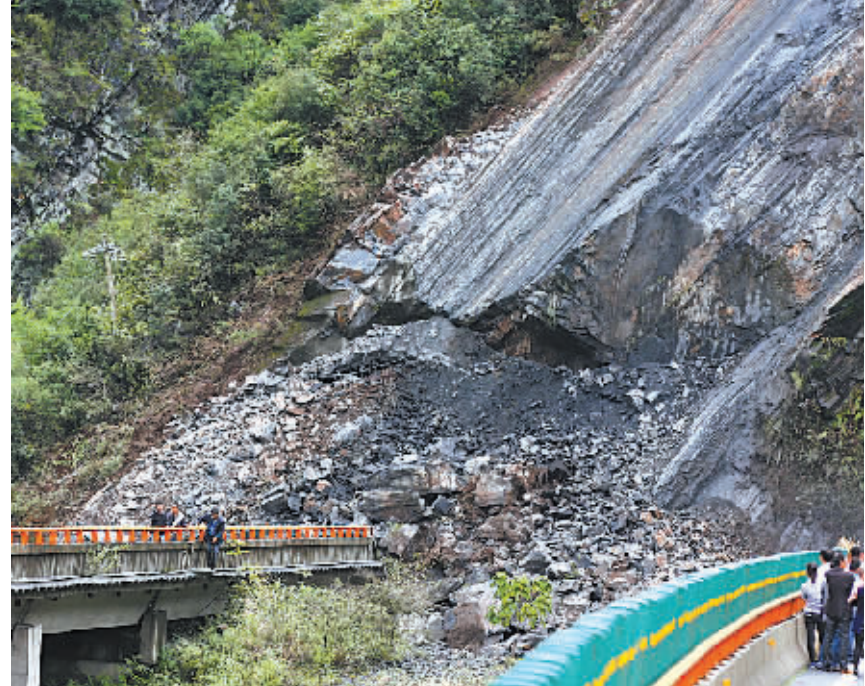
9月16日拍摄的包茂高速西康段塌方事故现场。9月16日上午，包茂高速公路安康至西安方向安沟隧道北口发生大面积塌方，造成该路段安康至西安方向罗瓦湾大桥约30米桥梁垮塌，事故未造成人员伤亡及车辆受损，相关部门正在组织人员进行道路抢修。目前该路段已经封闭，西安往返安康车辆双向均需绕行，通车时间还不确定。（新华社发）
