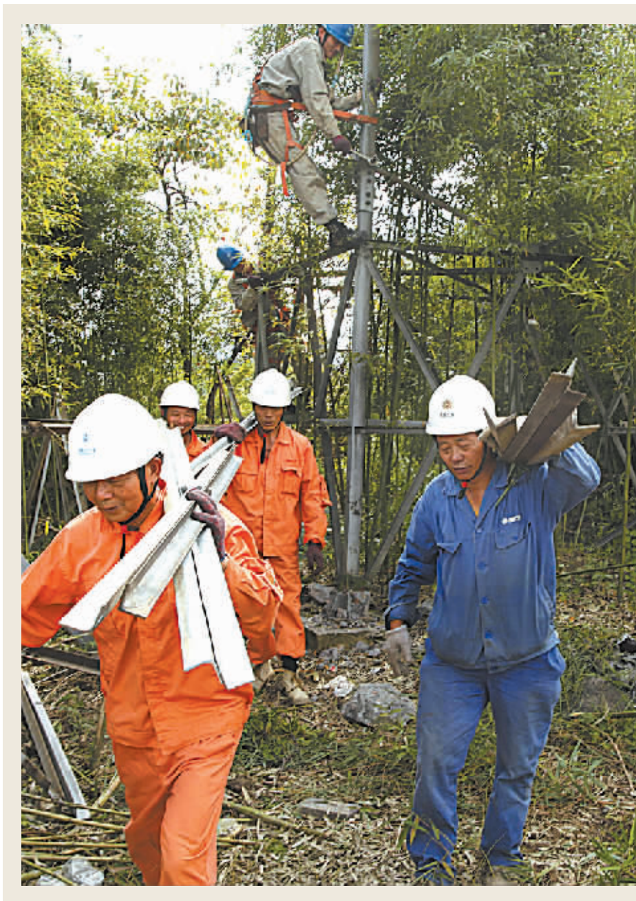
拆除挡道铁塔 推进轻轨建设
