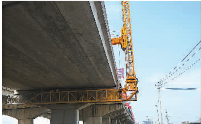
图：高科技桥梁检测仪。
