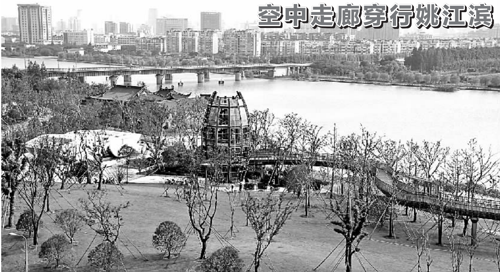
本报讯(记者王伊婧 通讯员孙思拓)江北区姚江北侧滨江绿化景观工程项目将于近日收官。该项目打造出了融江、河、廊为一体的
