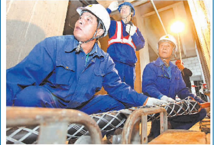
在东部新城宁波航运中心内,宁波电力配网公司施工人员正在用绞磨机把碗口粗的主电缆通上高楼。 (胡建华 王慕宾 谭智 摄)
