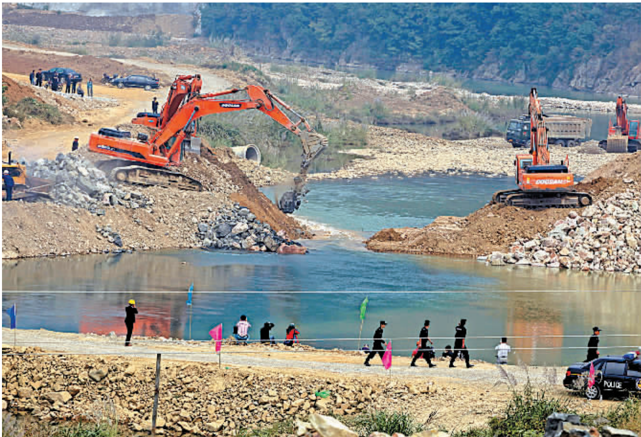
钦寸水库工程大坝围堰截流龙现场。
