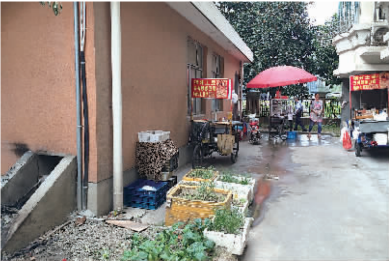
南裕小区配电房旁停放的烧烤车，左侧墙面黑色处为着火点。（王伊婧 摄）
