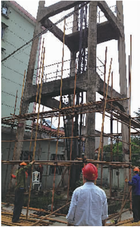
工人在拆除水塔。(通讯员供图)
