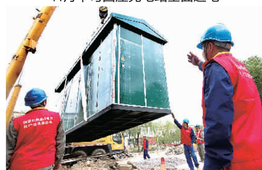
昨天，鄞州供电公司施工人员在鄞州金谷南路无轨电车充电站，把两台预制的箱式变电设备吊装到位。（胡建华 郑之超 摄）
