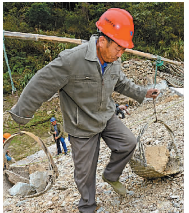
日前,在象山泗洲头镇胡村大岩头山塘整修施工现场,作业者在挑运石块。入冬以来,该县抓住水利建设黄金时节,以险库除险加固、河道整治工程、小型农田水利工程为重点,掀起冬修水利热潮。(徐能 陈光曙 张根苗 摄)
