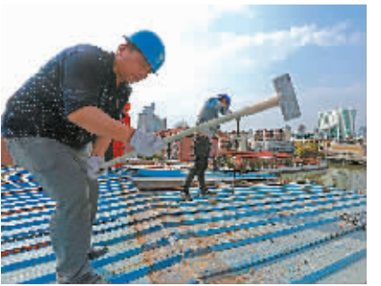
图为“空中违建”拆除现场。 （李超 摄）
