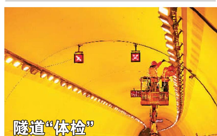
连日来，象山县公路管理段养护中心对管辖路段内20座隧道的供电、照明、排风、消防等系统进行全面“体检”，切实提高隧道通行环境质量，保障公众行车安全。图为检修人员在林善岙隧道内检修灯光系统。（金旭 徐能 陈光曙 摄）
