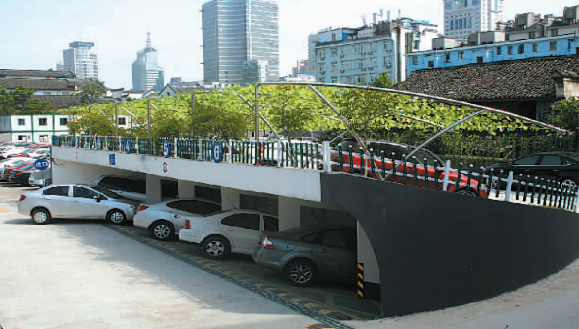
斜向泊车系统实景图。
