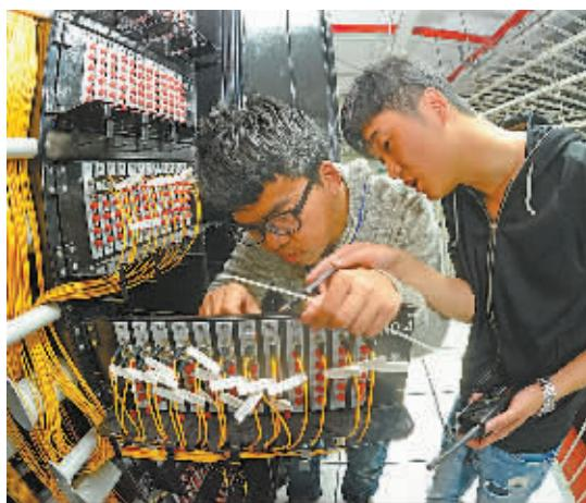
昨天下午,在中国移动数据处理中心(鄞州云计算中心),两名维护工程师正在进行ODF架尾纤放置。作为我市三年行动计划重大项目,工程总投资5亿元,由一期移动通信机房和二期云计算中心综合楼组成,集虚拟化、自动化、高性能、高安全性、绿色环保等于一体。目前,项目主体工程已全部完工并进入正式运营阶段,以云计算技术为核心的的数据中心将为宁波乃至全国知名企业提供服务器托管、云计算与大数据处理等服务。
