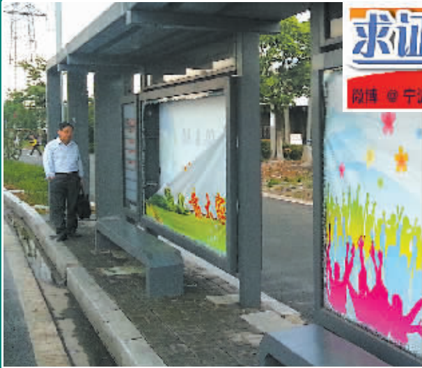
玻璃碎裂的公交车站。(记者 余建文 摄)
