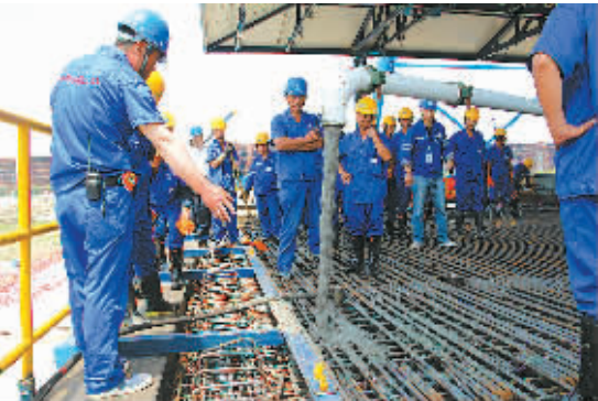
图为预制箱梁灌注现场。(张燕 徐清炜 摄)
