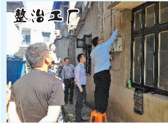
一楼生产、经营，二楼住人，这种“三合一”、“多合一”的小厂，在慈溪白沙路街道有不少。该街道经过专项整治，共督查合用场所332户，查找解决问题39项。图为检查现场。（景锦 摄）
