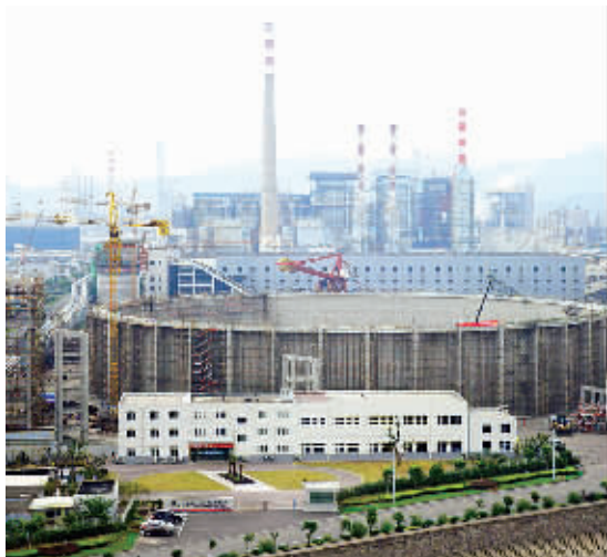
正在建设中的1号煤仓。（冯瑄 陈婷 摄）
