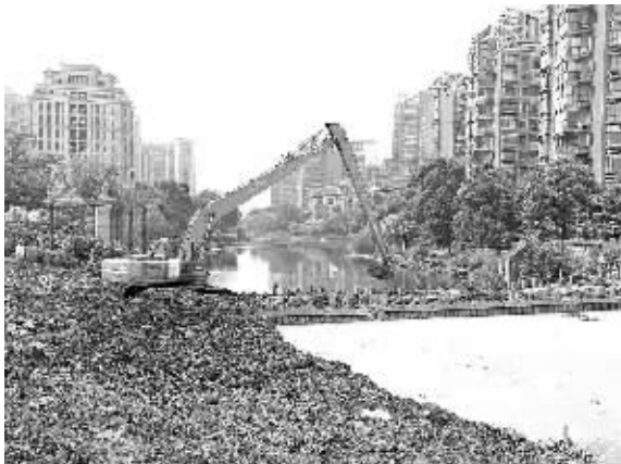
图为施工现场。（张燕 摄）
