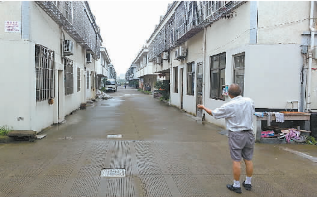
“朱韩花园”不少房子有违建,需要拆违之后才能领房产证。(记者 余建文 摄)
