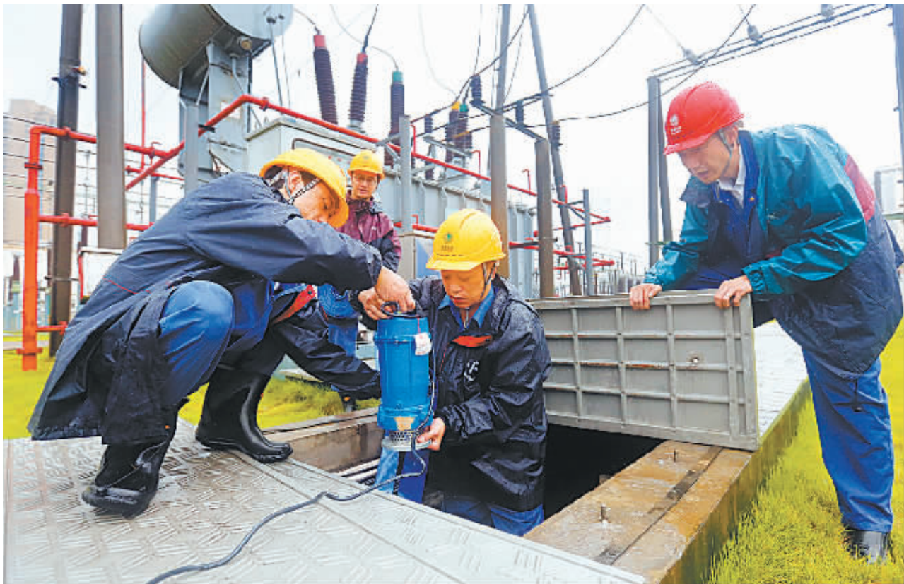
昨日，国网宁波供电公司工作人员用移动式水泵对电缆沟等部分低洼区域进行排水。台风逼近，重点变电站以及曾经受淹的低洼地段设备成为供电部门特巡、检查的重点。
