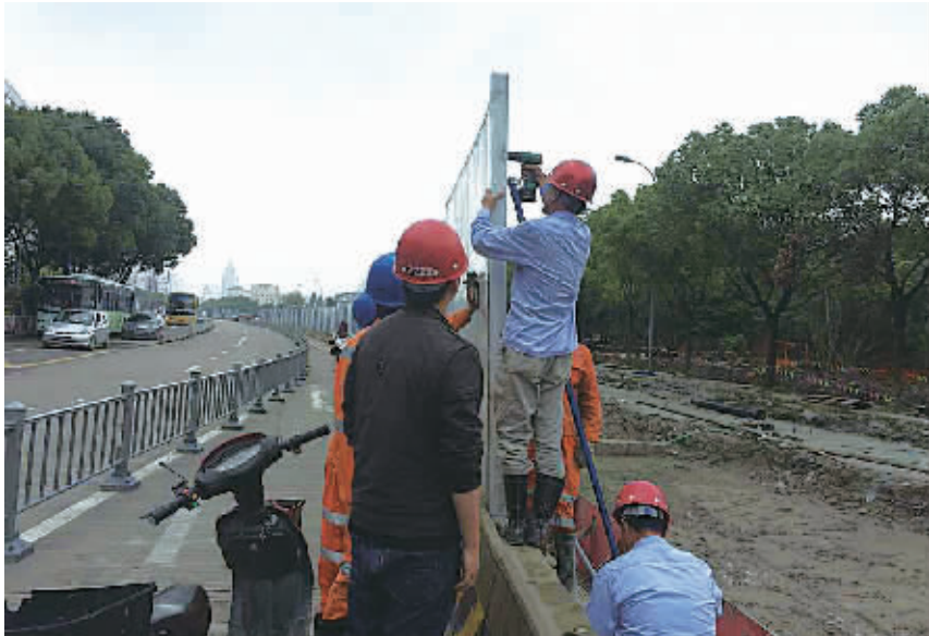
图为施工人员正在拆除围挡。
