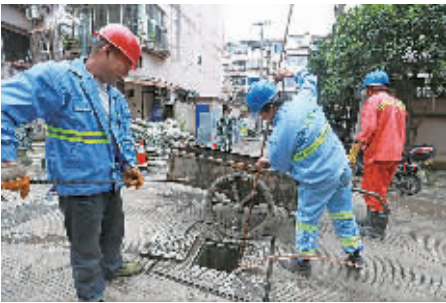
江东区城管局工作人员在王隘一村疏通下水道。(李超 摄)
