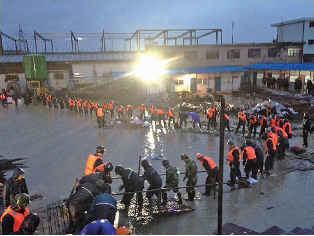
封堵剡江堤坝管涌现场。
