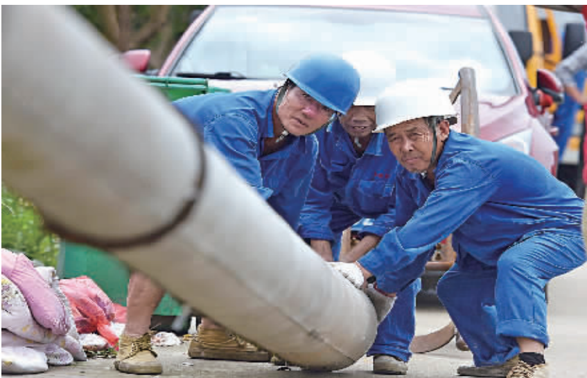
昨天，鄞州供电公司鄞江供电所工人正在上凌村更换被台风刮断的电杆。 (徐文杰 胡春华 摄)
