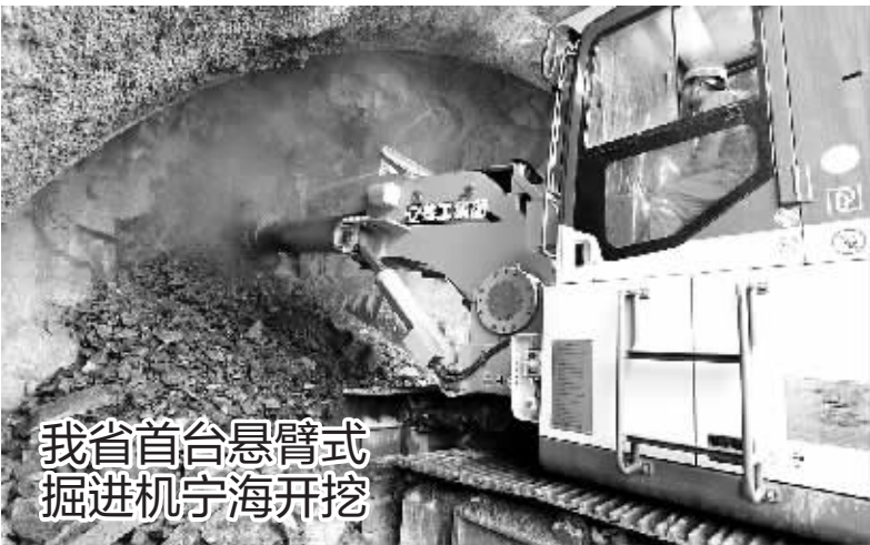
我省首台悬臂式掘进机宁海开挖 我省首台悬臂式掘进机近日开进38省道宁海县桥头胡至深明段的风潭隧道施工现场。宁海县交通局投资800余万元，引进了省内首台悬臂式掘进机，该机采用静态开挖，主要用于水库、公路、铁路周边爆破施工不允许条件下进行的隧道挖掘工作，可以杜绝由爆破引发的次生安全隐患，为隧道工程质量和施工安全提供双重保障。 （李江林 严龙 摄）
