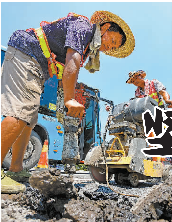
工人正用电锤清理破损路面。
