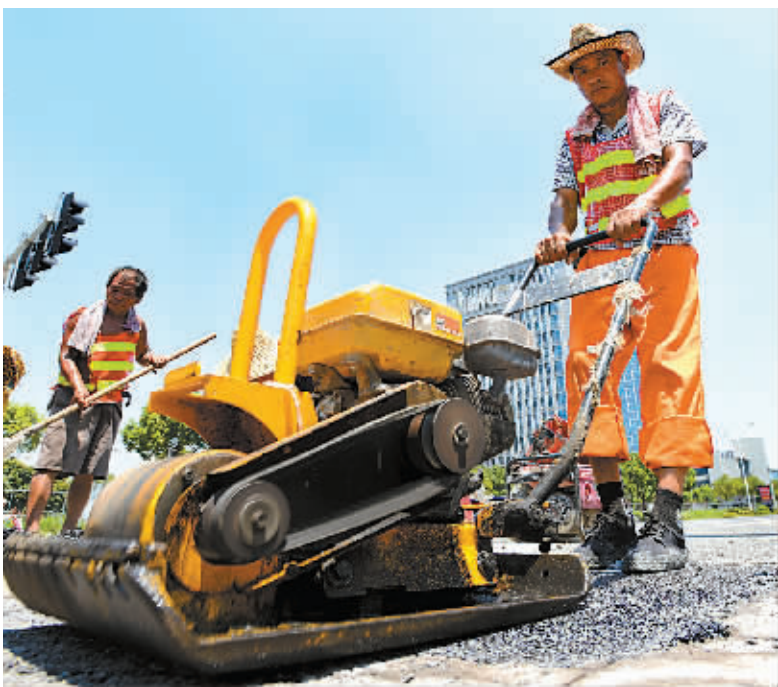
工人利用电动平板夯进行路面沥青摊铺作业。
