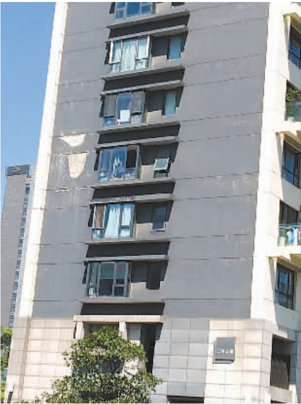
墙面水泥块多处脱落。(黄丽娟 摄)
