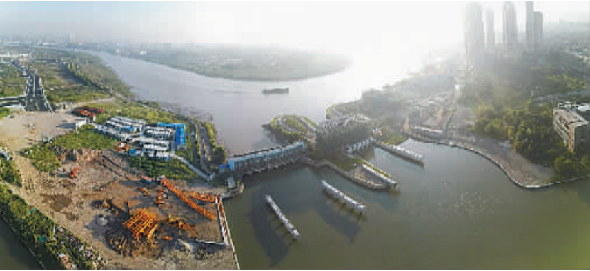
甬新闻泵站全景。
