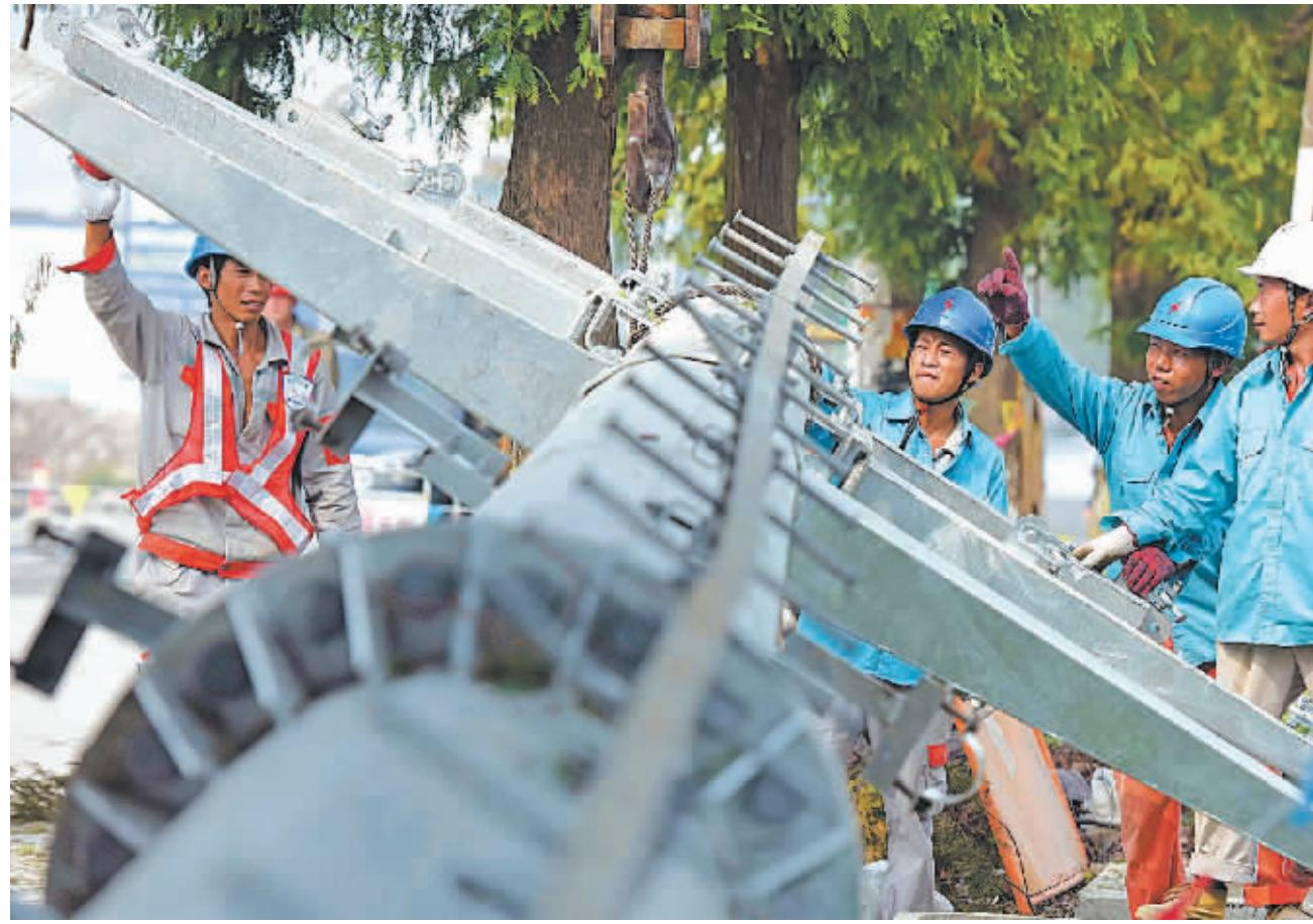
昨天上午，鄞州供电公司员工正在广泽路古林段吊装13.5米高的钢管杆，为电缆跨线作准备。至此，鄞县大道古林段到甬梁公路高桥段全长6.5公里的全线电缆落地工程完成。本月起，该公司将对境内公路两侧逐步实行电缆落地化。
