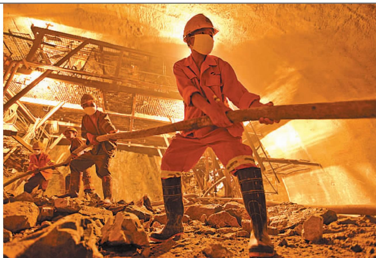
昨天上午,在北仑区梅山保税港区连接线工程隧道施工现场,施工人员正在进行爆破准备。据悉,该隧道全长1365米,开挖宽度为18米,分设人行道、货运车道和抢修车道,是我们目前最宽的在建隧道,建成后将与穿好高速、北仑集装箱二通道等相连接,分担南、北疏港交通。
