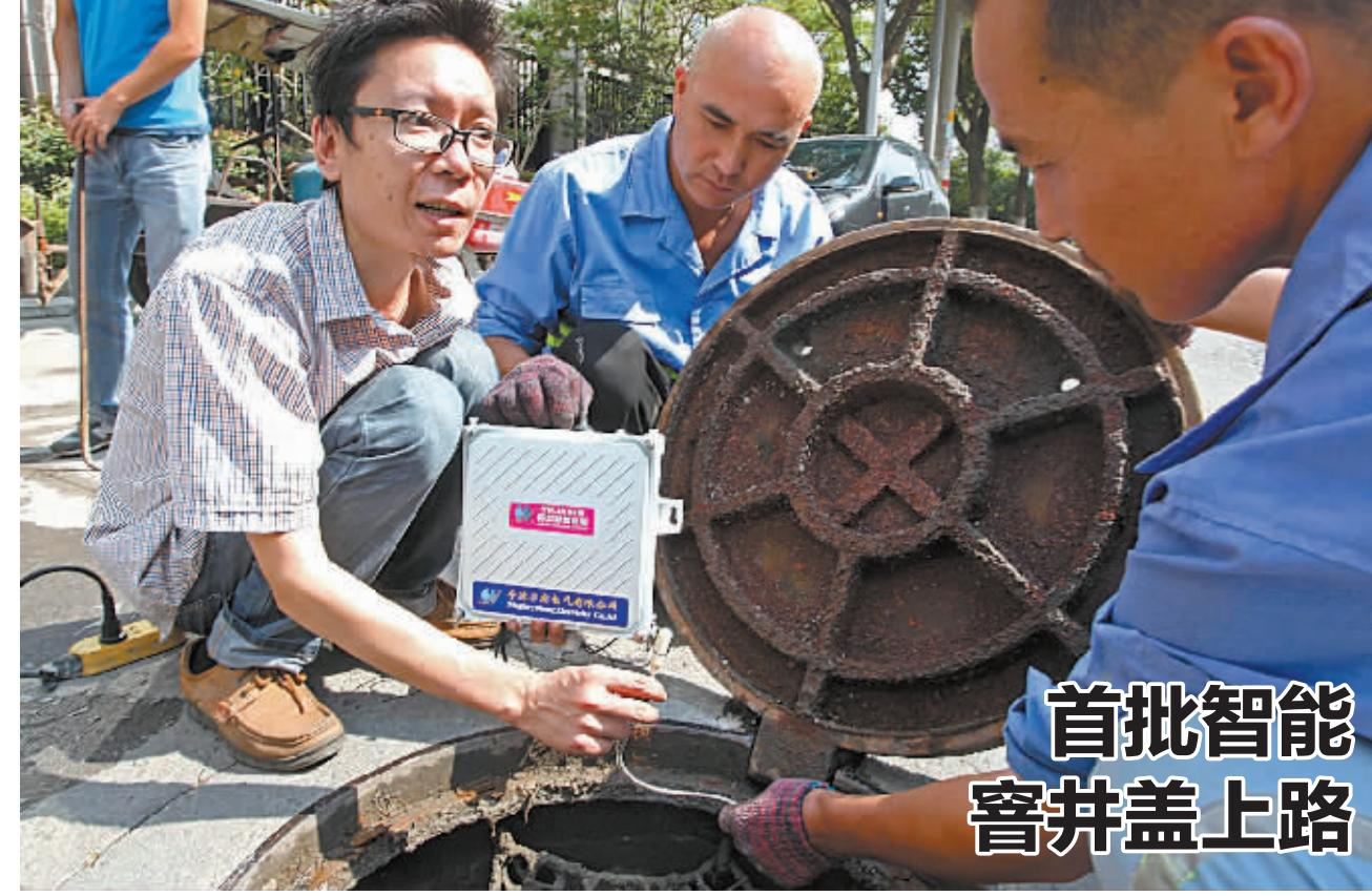
昨天,江东区城管局施工人员正在安装全市首批窨井盖智能感应器。此技术能够让城市道路上的井盖受重车碾压后出现破损、井盖缺失等异常情况时转入城管智慧化管理平台,并及时采取补救措施,以免危及车辆和行人安全。(徐文杰 杨拥 摄)
