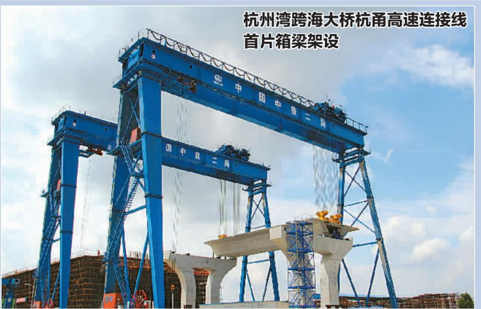
昨天,杭州湾跨海大桥杭甬高速连接线公路工程(余夫公路至小曹娥互通段)首片箱梁顺利架设,这为全线架梁工作的全面展开奠定了坚实基础。该项目全长约18公里,投资概算约47亿元,于去年6月全面开工,总体施工进度已过半。(徐清炜 徐文杰 摄)
