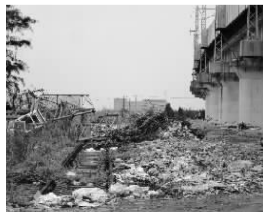
铁路高架桥下堆积的建筑垃圾。
